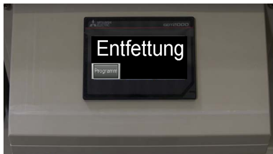
Prozessbedientableau zur Prozesssteuerung (Beispiel: Entfettung)
